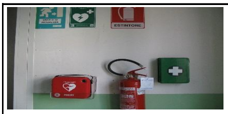
CORRIDOIO INGRESSO PALESTRA
