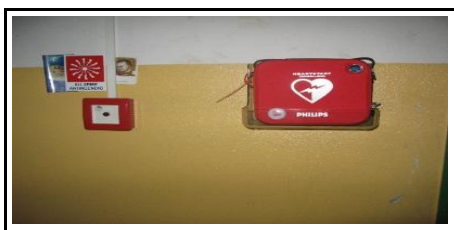
CORRIDOIO INGRESSO PALESTRA
